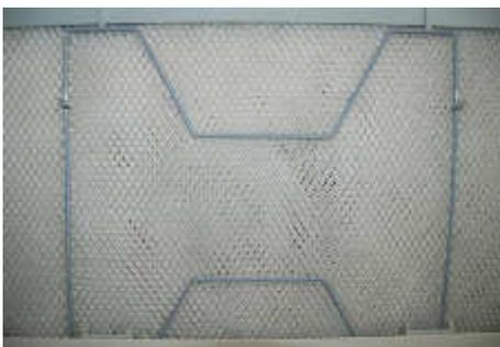
Abb. 32: Klemmbügel einsetzen
